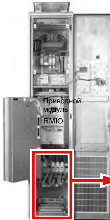
Привод типоразмера R6 без защитных щитков
