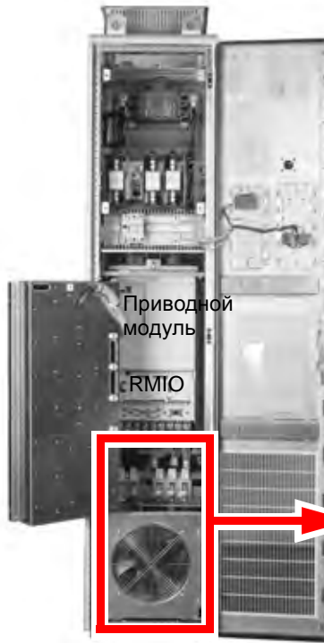
Привод типоразмера R6 без защитных щитков
